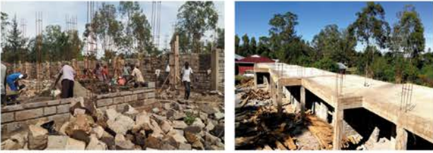
Hochbetrieb auf der Baustelle
